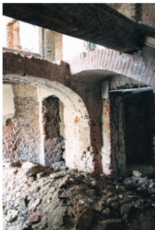
Илл. 1. Сохранившиеся сводчатые перекрытия на первом этаже
